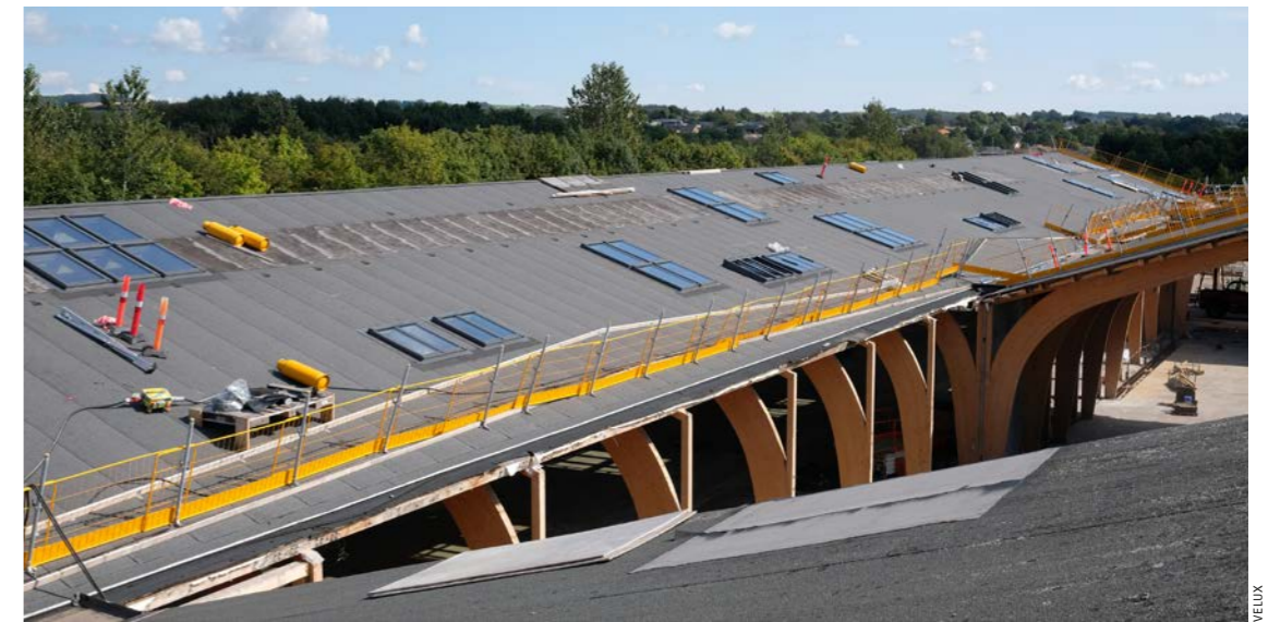
▲ In die Lagerhalle wurden die Atrien eingeschnitten und zahlreiche neue Oberlichter in den Dachflächen eingebaut
