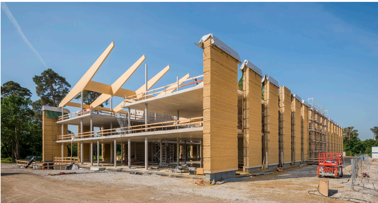
Bild 12: Rohbau mit Sicht auf die 12m hohen Wandscheiben. Fotograf: Marc Doradzillo
