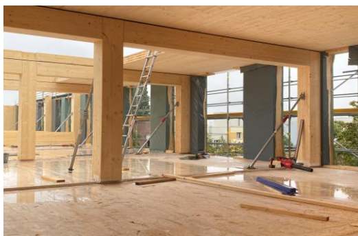
Abbildung 20: Holz-Rohbau
