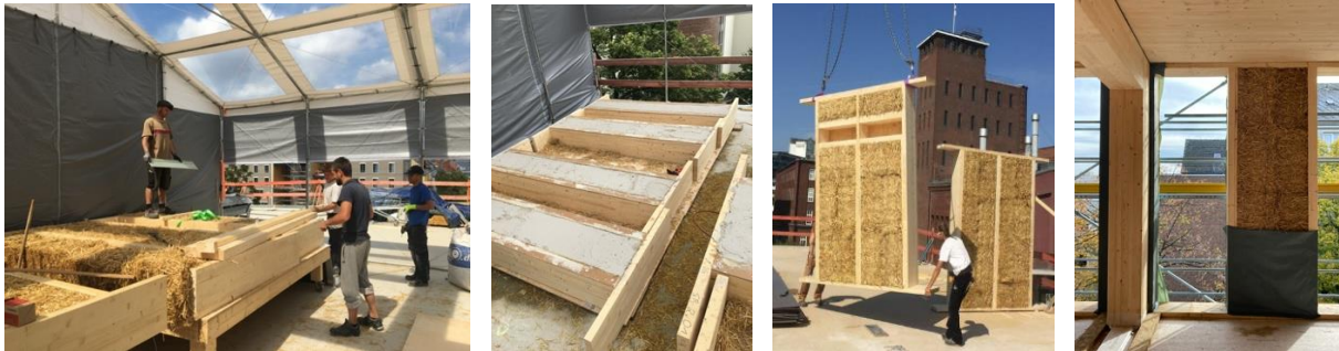
Abbildungen 21: Vorproduktion und Montage der Strohballenwand
