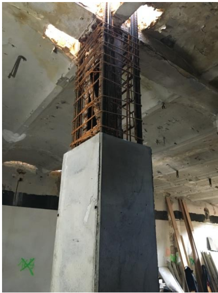
Abbildung 5: alter Stahl / neuer Beton
