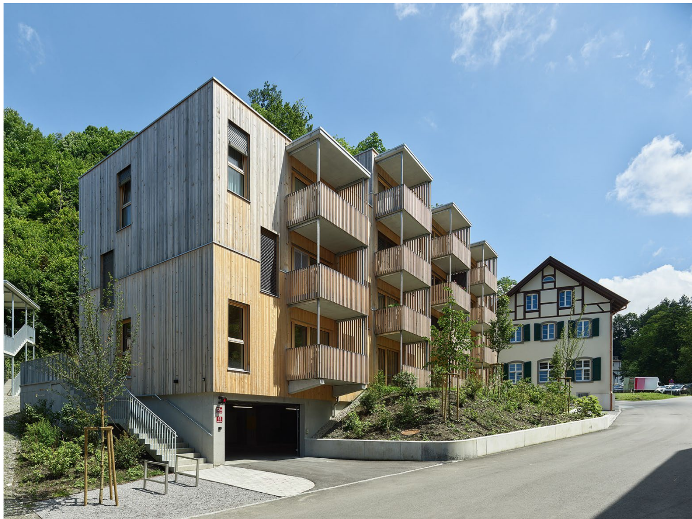
Holzwohnbau Müllerstrasse Dornbirn
