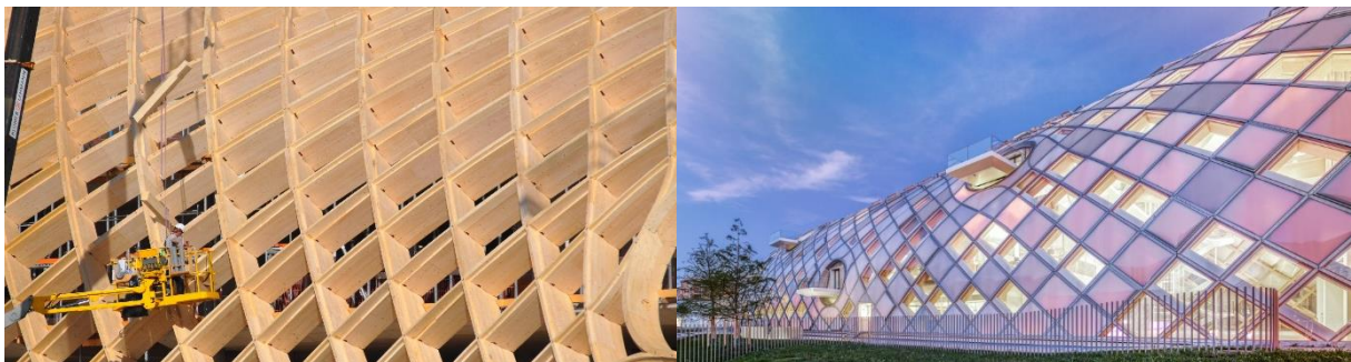
Abbildung 2: Montage der Holzstruktur und fertige Fassade (Bilder: SJB, Swatch)
