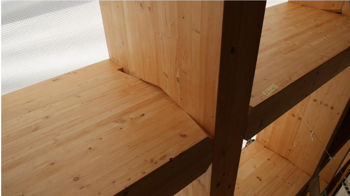
Abbildung 9: Detailansicht eines fertig montierten Knotens
