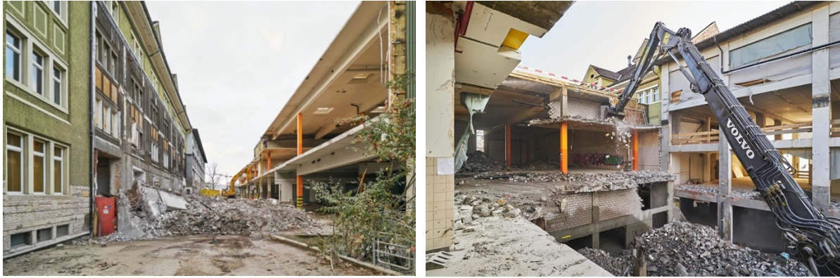
Abbildung 7: ELYS Teilrückbau des Gebäudes 215b zur Freilegung der gegenüberliegenden Fassade > neue Primarschule
