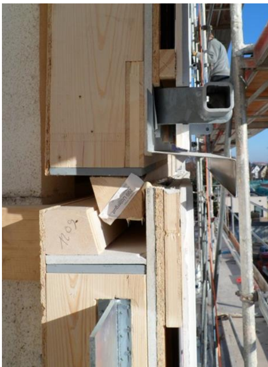
Abbildung 8: vertikaler Elementstoß
