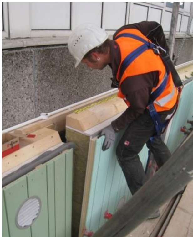
Abbildung 9: horizontaler Elementstoß
