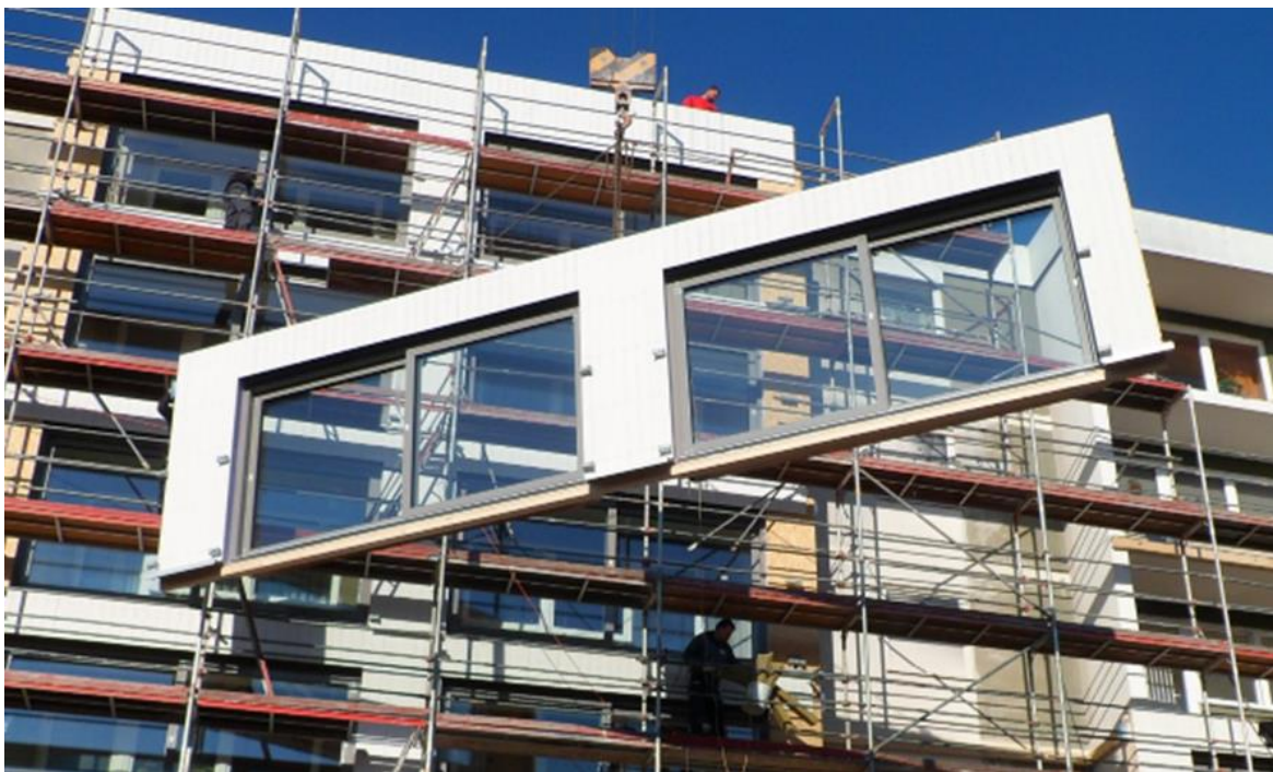
Abbildung 5: Montage TES Element
