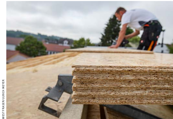
▲ Ausgestattet mit einer Nut- und Federverbindung lassen...
