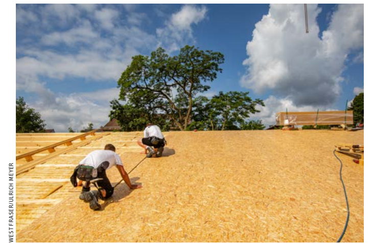
▲ ...Schalung für einen Dachstuhl verarbeiten
