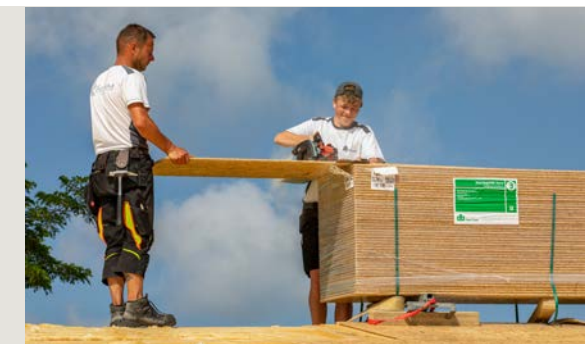
▲ Abgelängt wurden die OSB-Platten mit einer Handkreissäge und befestigt...
