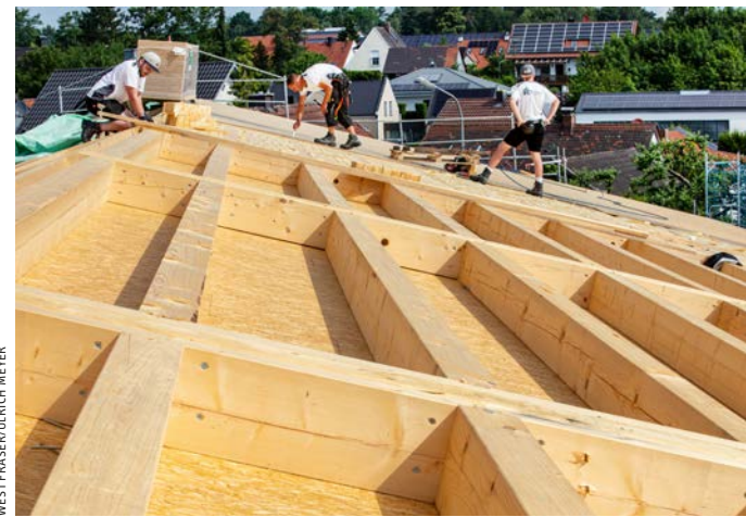
▲ ...Lagerhalle vom Bauhof der Markt Ergoldsbach verbaut. Die Platten entsprechen der Norm EN 300 und...
