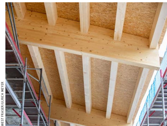
▲ Mehr als 2000 m 2 SterlingOSB/3-Zero hat die Holzbau Rehm GmbH als Untersicht und Dachschalung im Satteldach der neuen...
